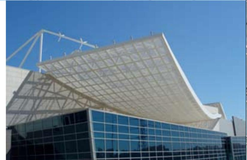
Skylights mit punktgehaltenen Gläsern, sowie ca. 8.000 m<sup>2</sup> Lichtgaden. An den Enden der Einkaufsboulevards bilden insgesamt zehn seilhinterspannte Fassaden mit ca. 3.600 m<sup>2</sup> die Gebäudeabschlüsse. Des Weiteren liefert MERO ca. 14.500 m<sup>2</sup> Verschattungsdächer. Hiervon sind ca. 3.500 m<sup>2</sup> von Masten abgehängte Strukturen über den Gartenbereichen sowie ca. 11.000 m<sup>2</sup> auf Stützen stehende Konstruktionen über Park- und Dachflächen.
